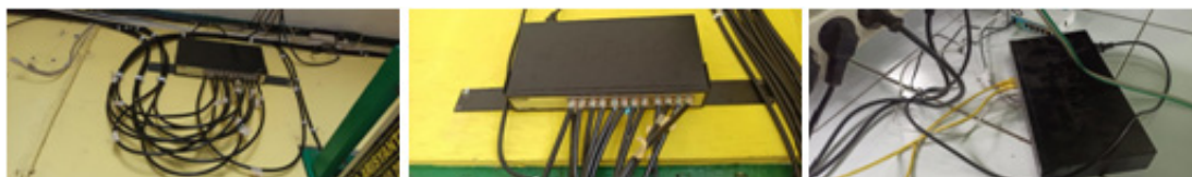
Gambar 5 Pemasangan Jaringan UTP dan Switch
