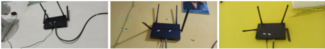
Gambar 6 Pemasangan Acces Point ke Kelas-kelas
